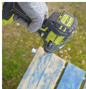
*Percer le bois au diamètre de vos boulons puis positionner vos lattes de bois pour percer la structure avec un foret métal.*
